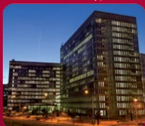
Centra danych w budynkach
